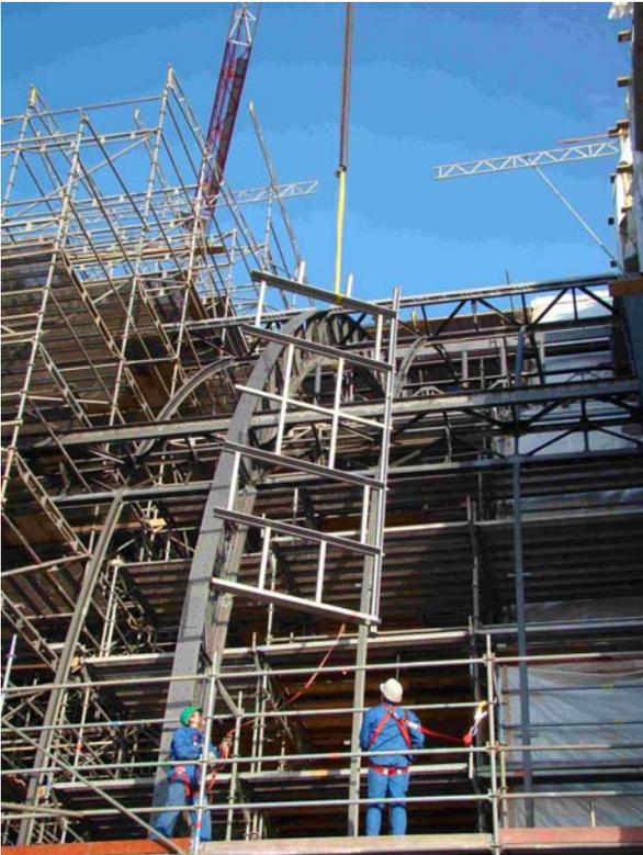
Das erste leiterartige Fassadenelement wird zwischen historischem Stahlträger und Gerüst eingefädelt (Foto: M. Krebs).
